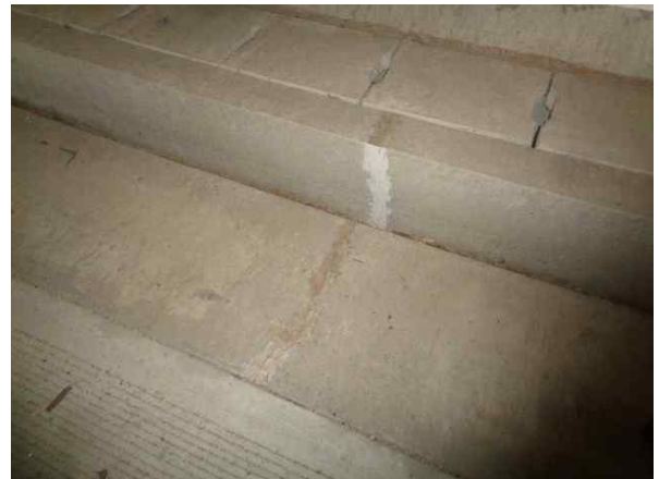
공동구 S08 균열 보수완료-문산방향
