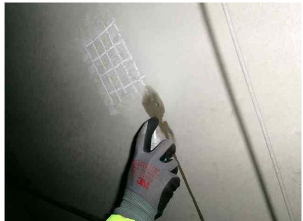
탄산화깊이 측정 현황
