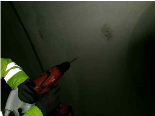
탄산화깊이 측정 현황
