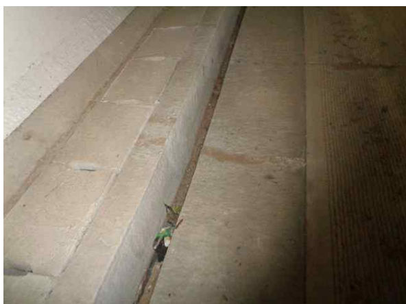
포장부 S10 갓길측 균열 보수완료-문산방향
