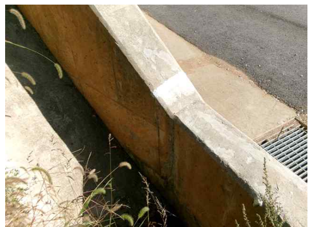
시점측 갭문 균열보수-서울방향
