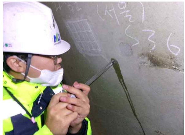
탄산화깊이 측정 현황
