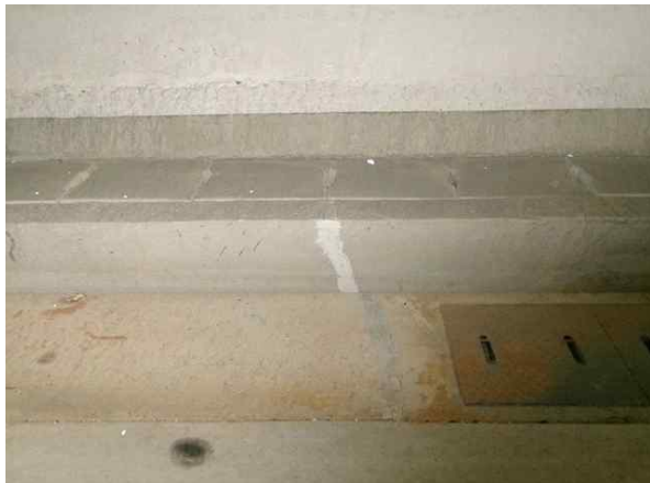
포장부 S27 균열 보수완료-서울방향
