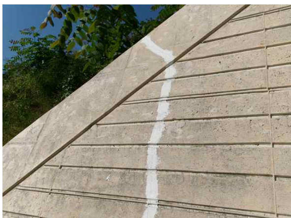
시점측 갭문 균열보수-서울방향
