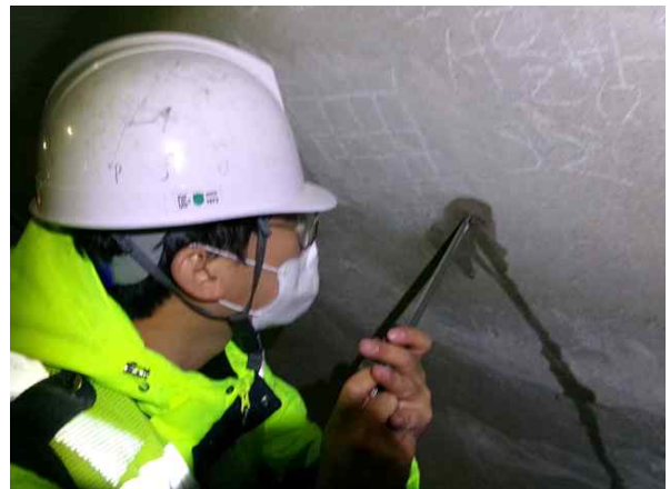
탄산화깊이 측정 현황
